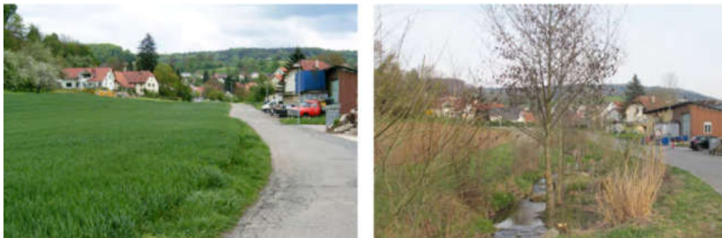
Abbildung 16: aus dem Merkblatt; Egliswil: Bachöffnung Hasenmoosbach aufgrund der Bautätigkeiten mit neuer Kanalisationserschliessung.
