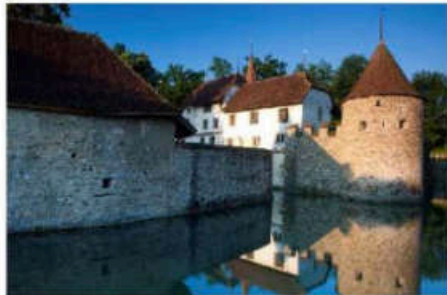
Das Wasserschloss Halwyl
