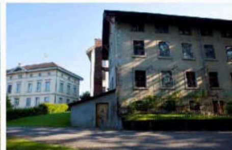
Historische Industriebauten von Meisterschwanden
